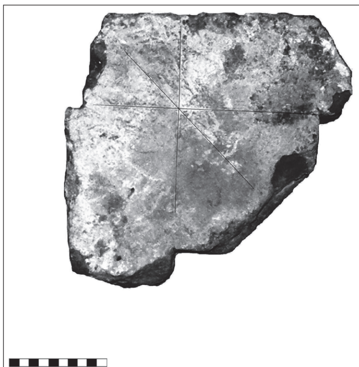
Ilustr. 3.1 - 3.2. Przykłady znaków montażowych umiejscowionych na konsolach pochodzących z dawnego klasztoru augustianów w Stargardzie. Fot. K. Krawczyk
