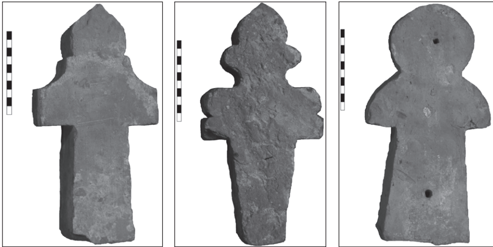
Ilustr. 1.1 – 1.5. Najlepiej zachowane pełne formy kształtek profilowanych do żeber sklepiennych z dawnego klasztoru augustianów w Stargardzie. Fot. K. Krawczyk
